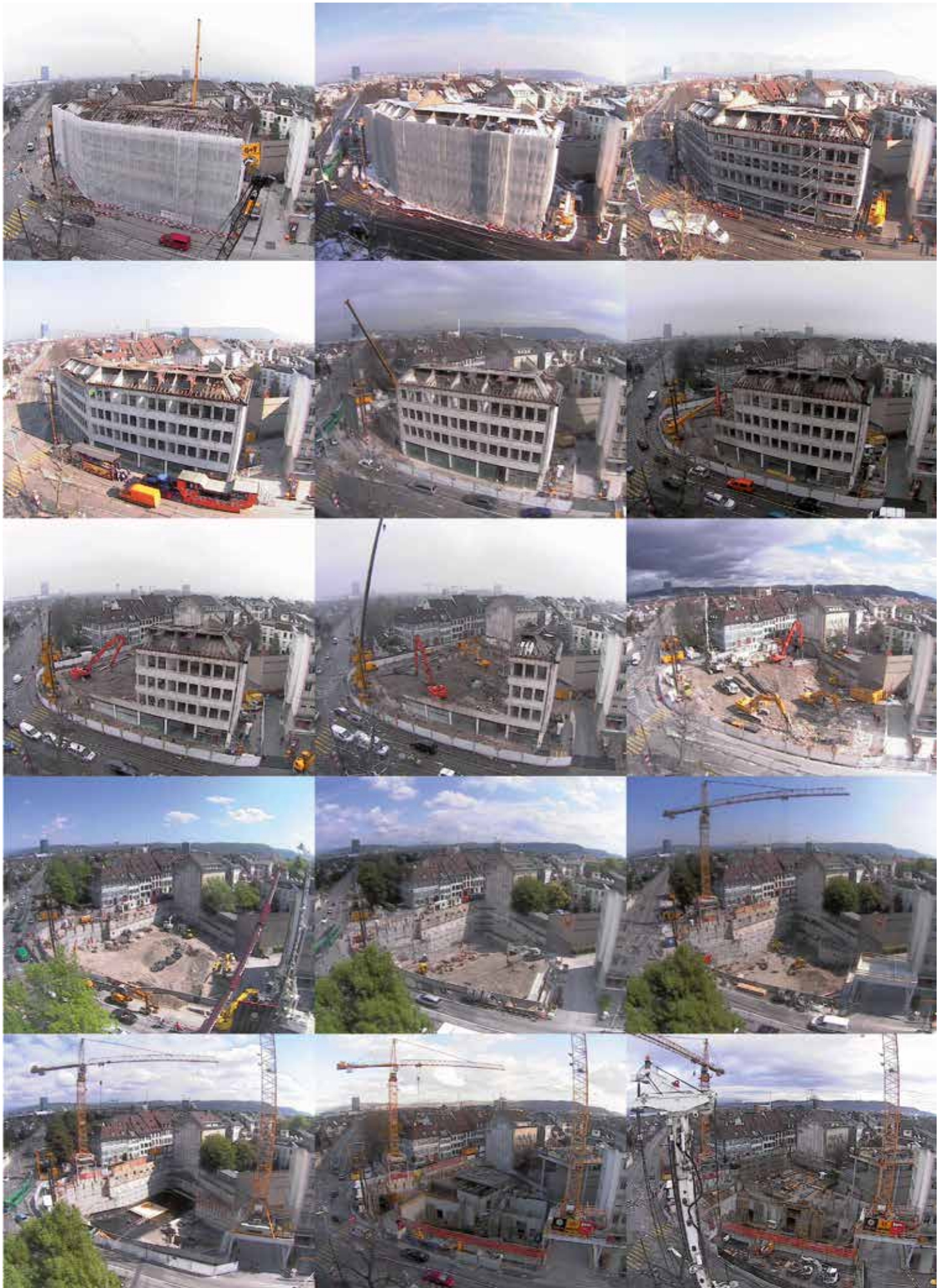
Rückbau des Burghofs
